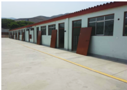
MANTENIMIENTO Y REPARACIÓN DE 20 PUERTAS
